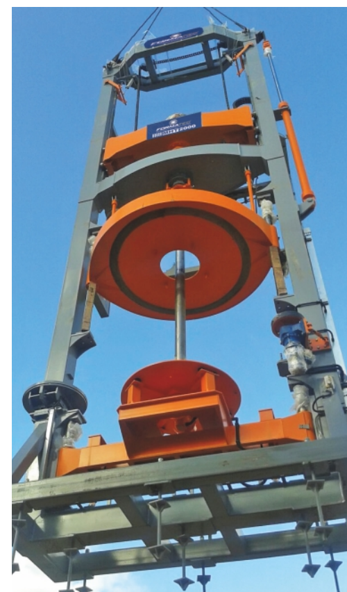
Instalação da Torre Principal
