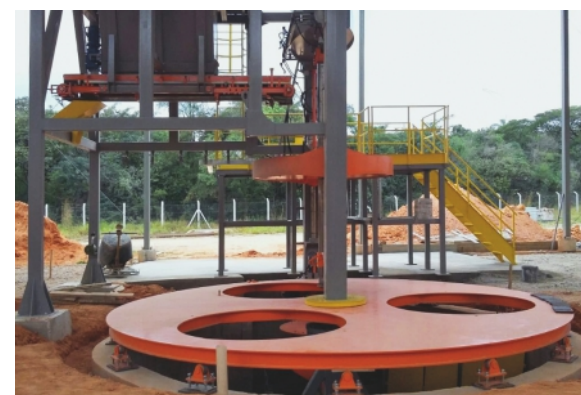
Instalação da Plataforma Giratória
