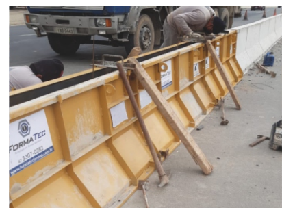
Barreira New Jersey Simples Concretagem In-Loco
