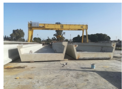
Viga tipo "V" com Console Lateral
