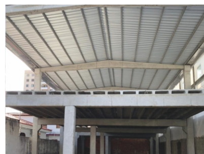
Forma Simples para Viga Calha
