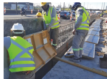
Barreira New Jersey Simples Concretagem In-Loco
