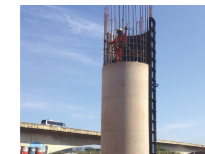
Travessa – Concretagem In-Loco
