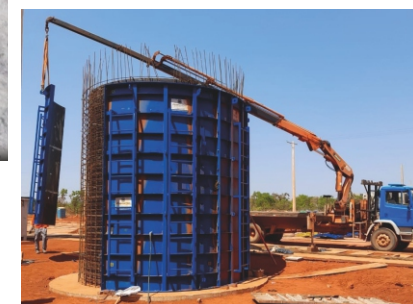
Caixa da Água Concretagem In-Loco
