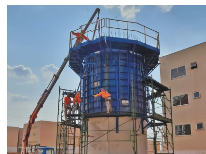
Caixa da Água Concretagem In-Loco
